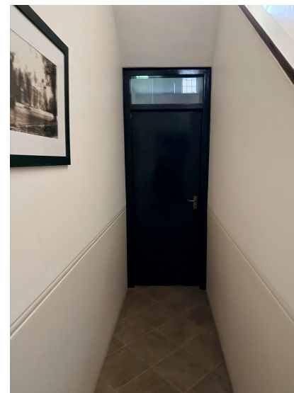
existing basement door
