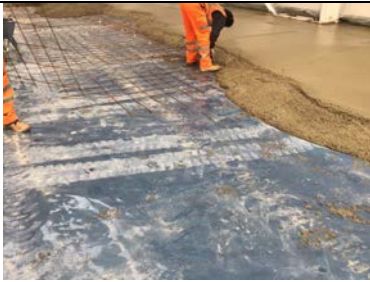
Overview of the pour progressing.
