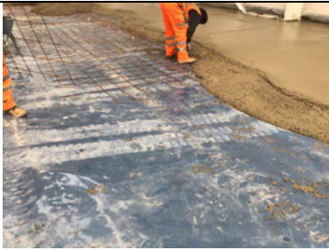
Overview of the pour progressing.
