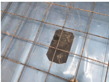
Repaired damaged membrane using Juta GP1 SAM.
