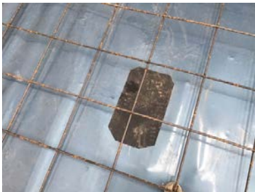
Repaired damaged membrane using Juta GP1 SAM.
