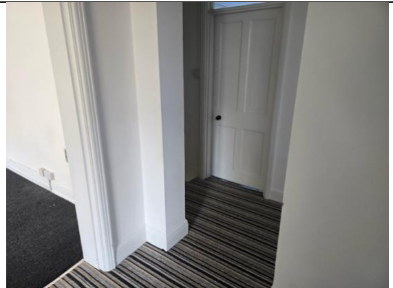
No 68 room F.06 (landing)
