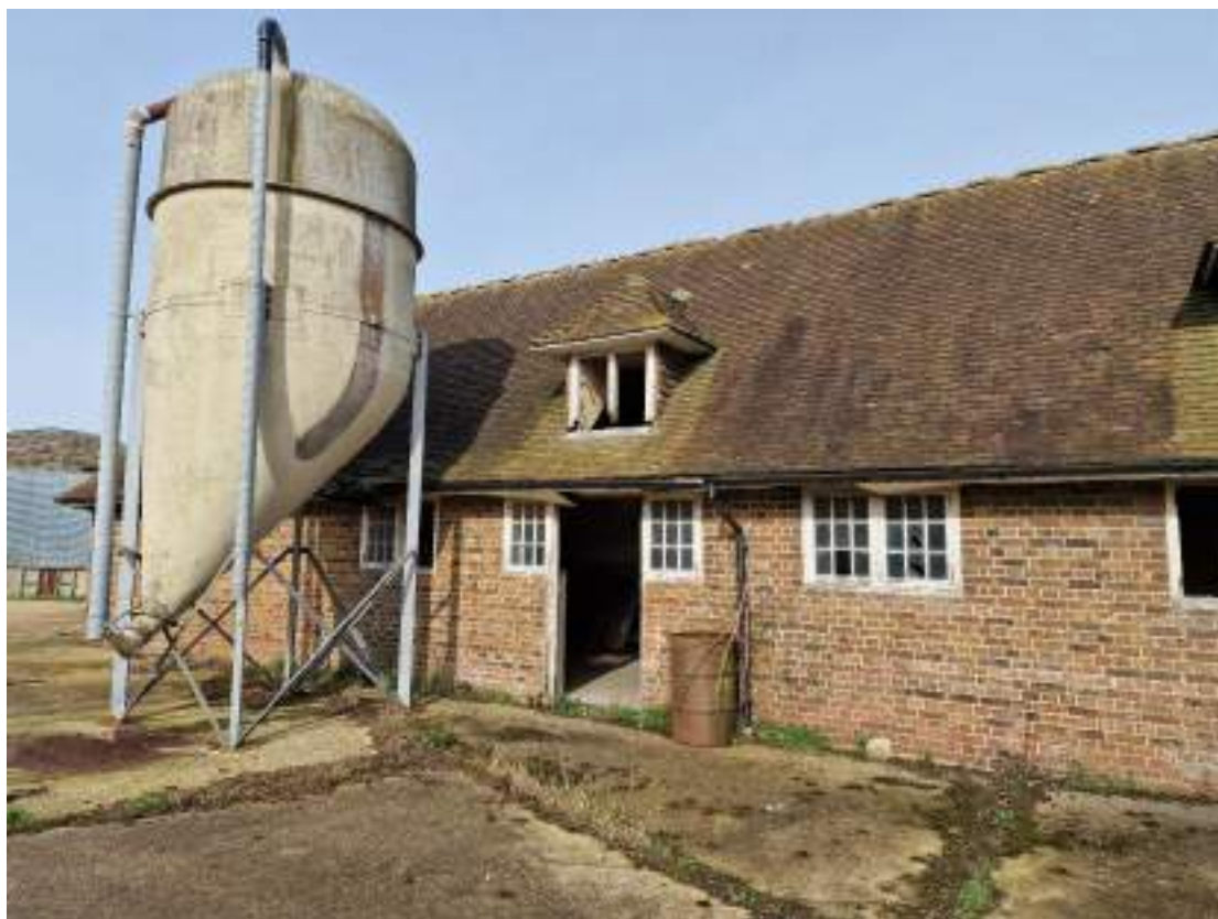
B1 exterior silo
