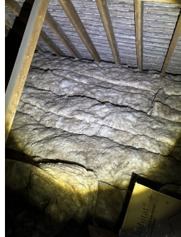
B1 loft void.
